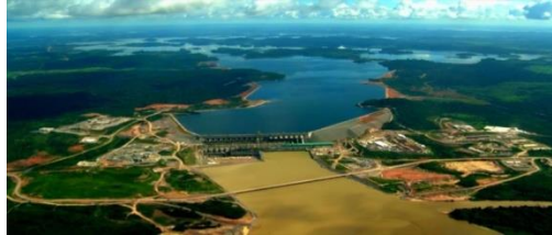
Figura 1 - Foto aérea da hidroelétrica de Belo Monte, localizada na volta grande do Xingu.
